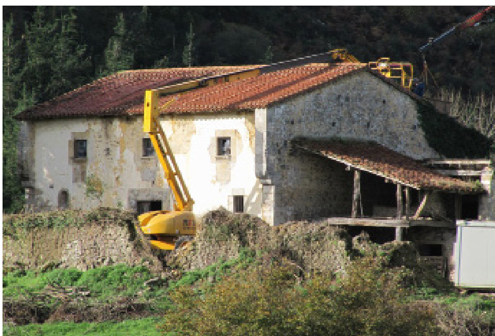
Arriba derecha e izquierda: Imágenes de la Casona de Umpiones antes de la restauración.
