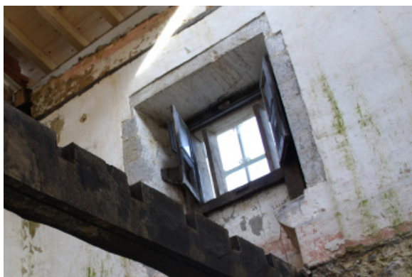
Arriba: Detalle de ventana con festejador antes de la rehabilitación.
